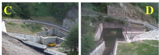
Vasca di sedimentazione intermedia del Rogno alla confluenza della valletta sulla sponda sinistra e varie opere di sostegno della scarpata stradale: nel 2012 (C) e nel 2016 (D)
