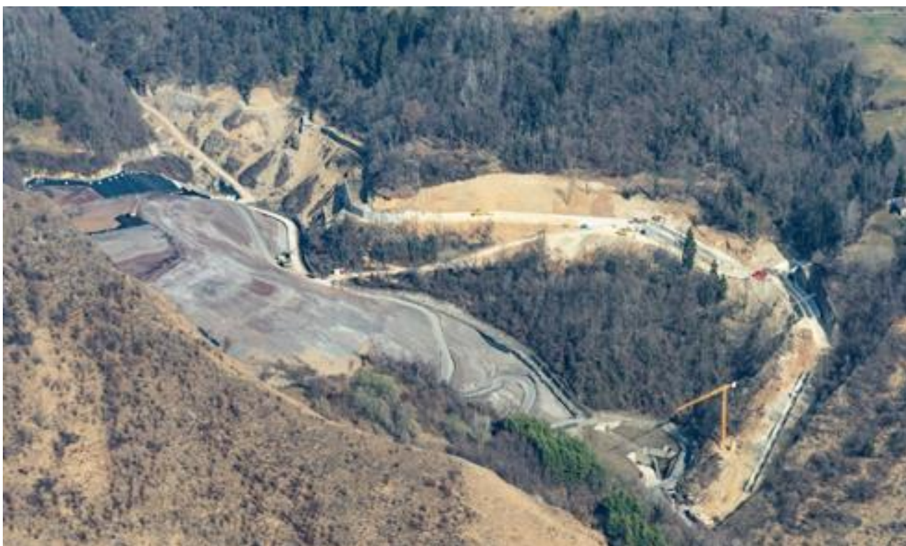
Lavori in corso nella Valle di Rogno a marzo 2022 (vista da sud(crinale Monte Frol))
