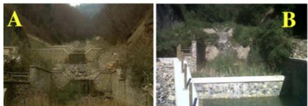
Brighe e la vasca di sedimentazione nell'alveo del Rogno a monte della discarica nel 2009 (A) e nel 2016 (B)
